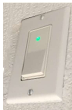
Interrupteur à bascule LED installé dans la plaque murale.
